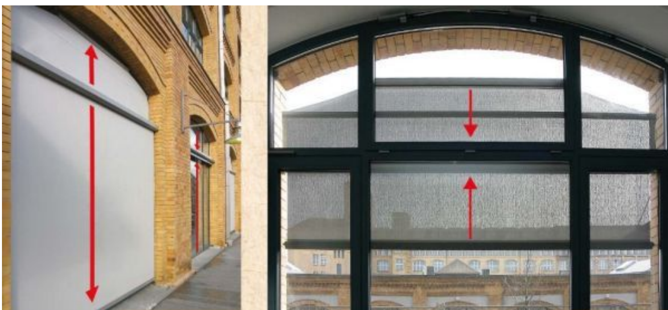
Fassadenmarkise im Kämpferprofil installiert von der Seite ausfahrbar: 20 m, von oben nach unten: 8m breit und 14 hoch, von unten nach oben bis 22 m hoch
