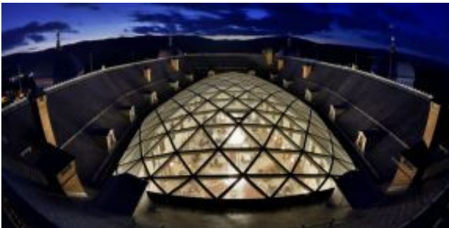
Atriumverschattung im Schloss Außenansicht
