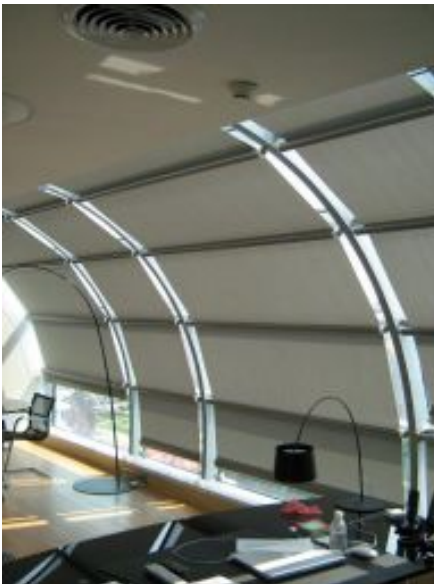
Sommerlicher Wärmeschutz innen
