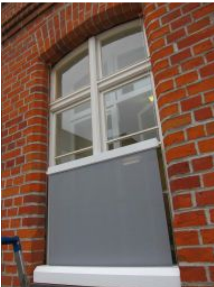
Fassadenmarkise von unten
