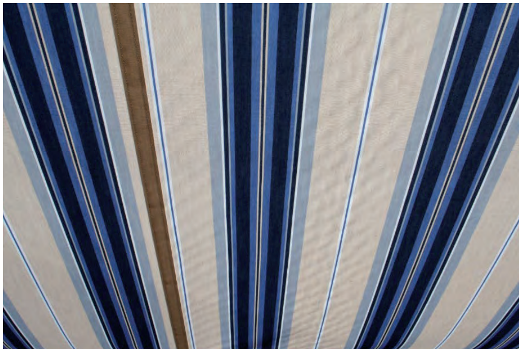
Bild 9.1.10 Zulässige Welligkeit im Bahnbereich (Wabenbildung)
